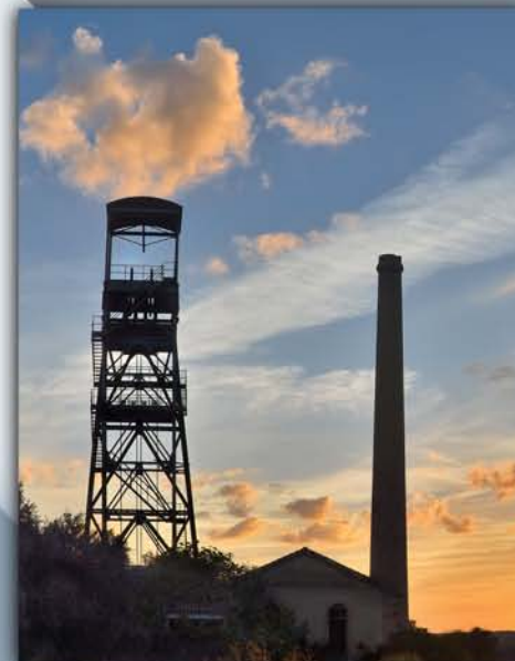
Pozo Esmeralda. Mina de San Juan (ADARO)
